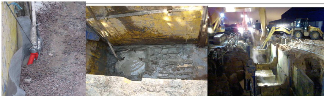
Рис 54 Водоотлив из траншеи
