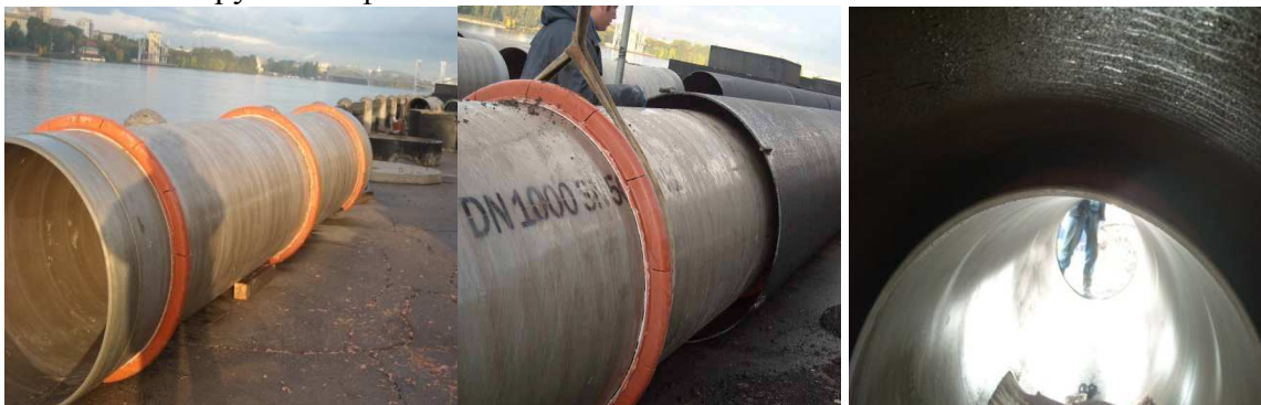
Способ протаскивания труба в трубе
