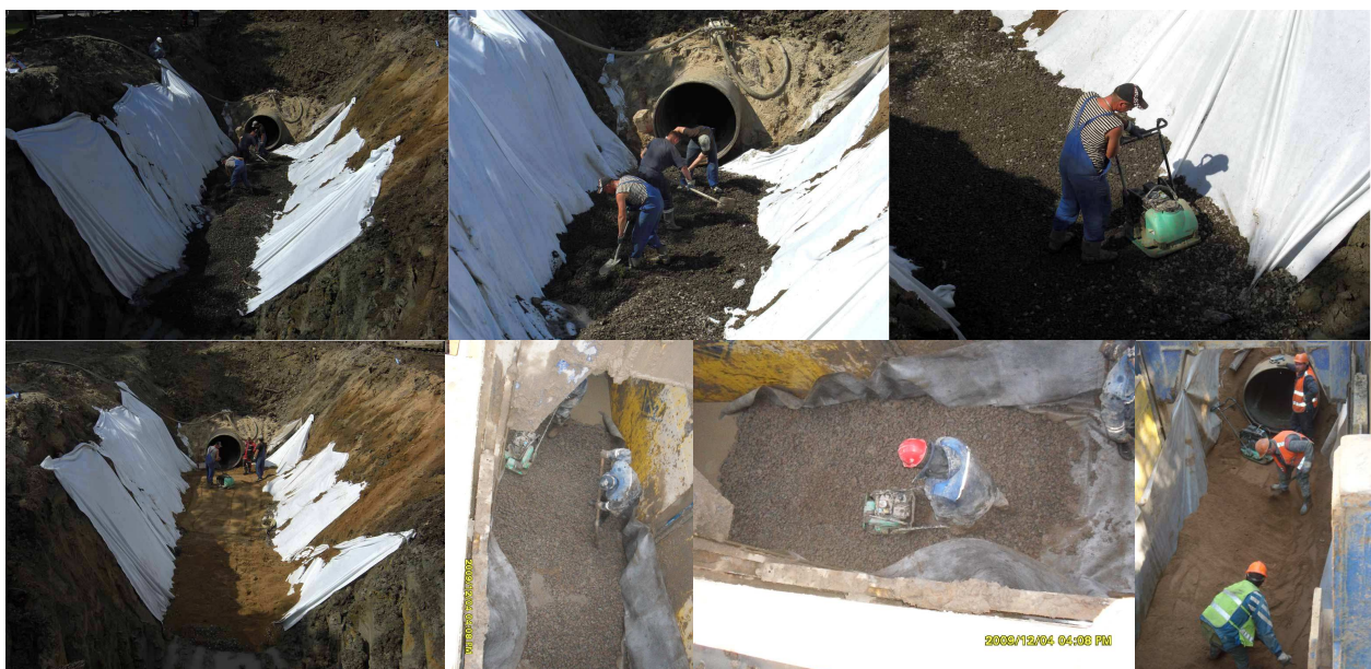
Рис 56 Устройства оснований под трубы
