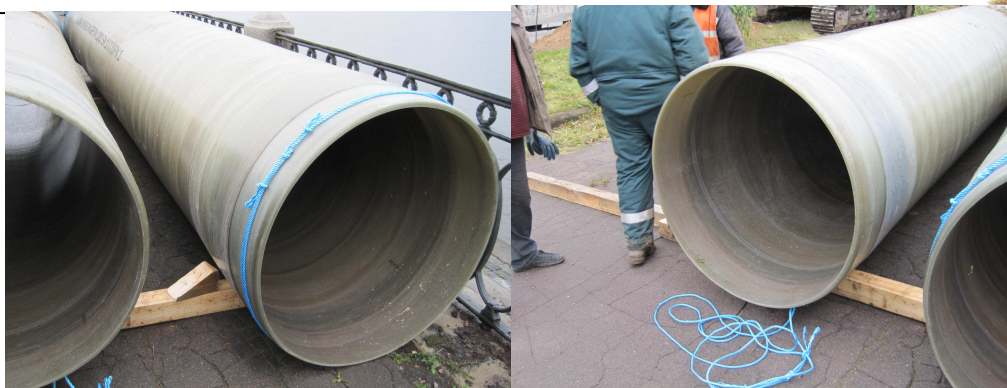
Рис 52 Складирование труб на площадке
