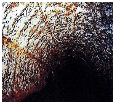
Внутренняя поверхность ж/б коллектора с применением стеклопластиковых труб Helyx
