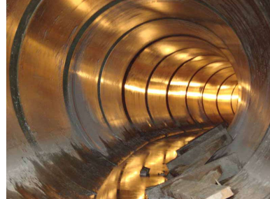
Внутренняя поверхность ж/б коллектора с применением стеклопластиковых труб Helyx
