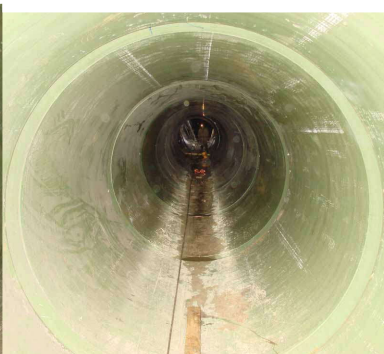
Внутренняя поверхность ж/б коллектора с применением стеклопластиковых труб Helyx
