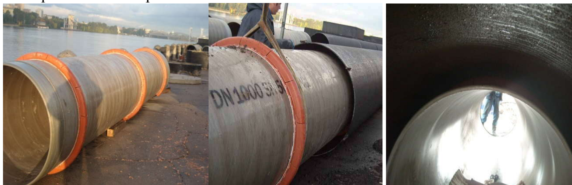
Способ протаскивания труба в трубе
