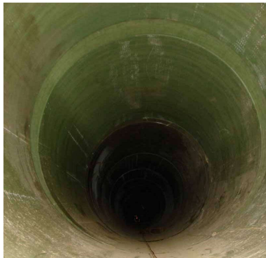
Внутренняя поверхность ж/б коллектора с применением стеклопластиковых труб Helyx
