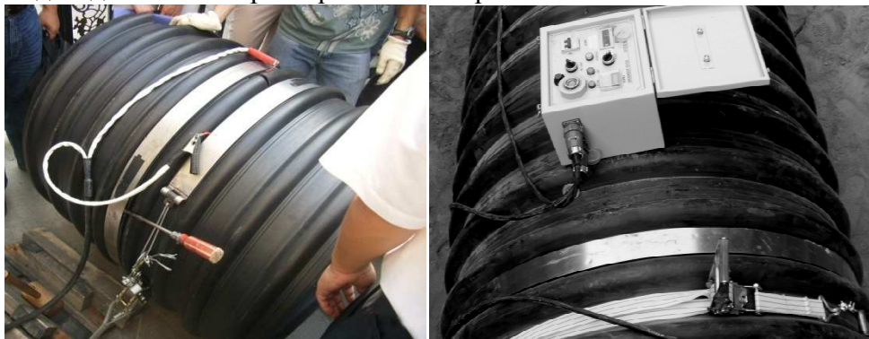
Рисунок 3. Процесс сварки
