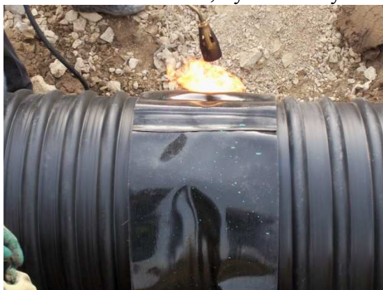
Рисунок 4. Процесс плавления термоусадочной муфты.
