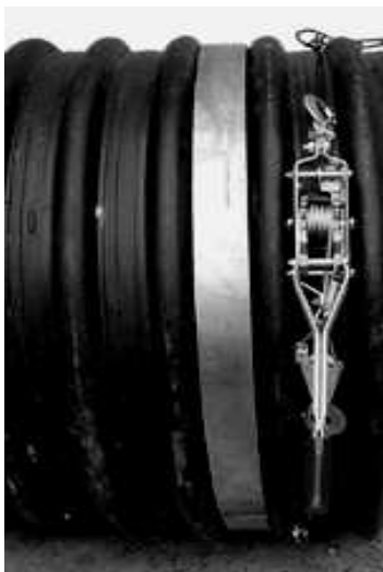
Рисунок 2. Стягивание лент при помощи лебедки.
