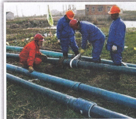
Фрагмент монтажа стекловолоконных труб с муфтово-резьбовым соединением.
