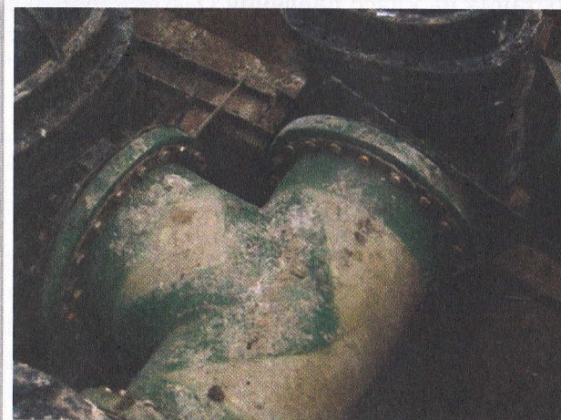
Фрагмент фланцевого соединения с металлической задвижкой DN600 мм PN0,6 МПа SN 10000 Н/м 2 . г.Бухара, Узбекистан.
