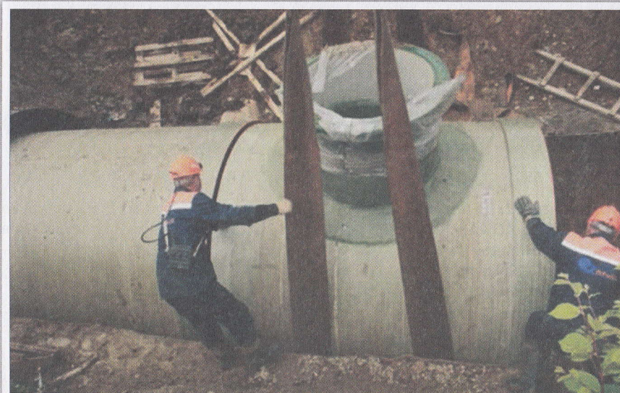
Фрагмент монтажа стекловолоконного тройника DN2600x900 мм PN 0,6 МПа SN 7500 Н/м². Невинномысская ГРЭС, г. Пятигорск, РФ.
