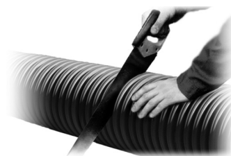
Рис. 1.4. Резка ПП гофрированных труб
