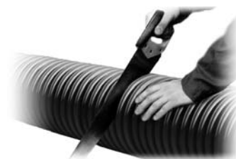
Рис. 1.4 Резка ПП гофрированных труб
